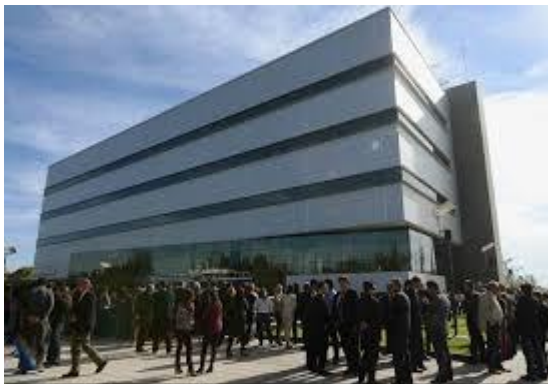
Figura 13. Edificio principal de la Tercera Circunscripción Judicial. Ubicado en San Martín.
