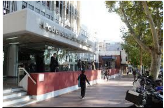
Figura 12. Edificio II ubicado en calle San Martín
