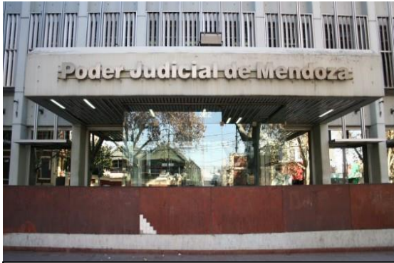
Figura 11. Edificio II ubicado en calle San Martín
