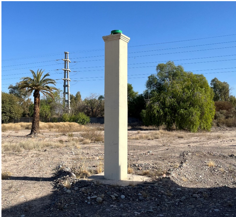
Figura 2: Pilar punto OAFA (Antena GNSS)
