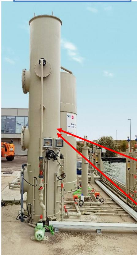
Sistema de dos etapas para la producción de polihidroxicanoatos (PHAs), a partir de  $60 \text{ m}^3\text{d}^{-1}$  de biogás.
