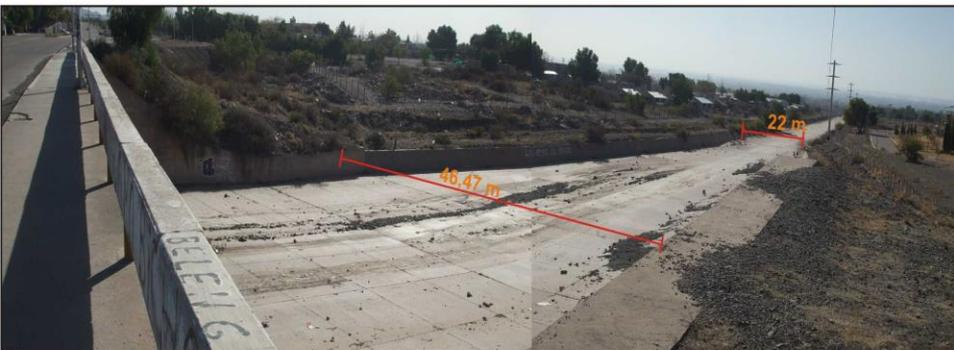
Figura 38. Inicio del canal de evacuación de excedentes Papagayos. Aguas abajo puede divisarse los altos niveles de población que lo rodean, además de la pendiente a través de la cual circula el agua durante eventos de alta pluviometría.
