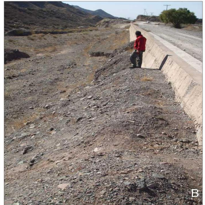
**Figura 22.** Imágenes fotográficas A y B en las cuales pueden observarse los depósitos de material aluvial de las últimas crecidas, puede verse que estos presentan similar altura que el dique. En líneas azules en la imagen A puede apreciarse la dirección de escorrentía del río, la altura se corresponde con 5.15 metros aproximadamente.
