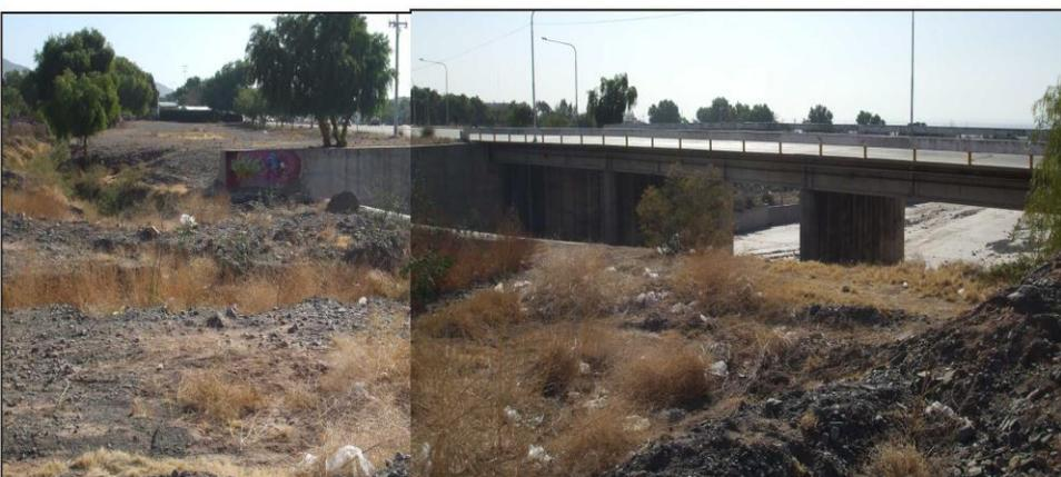
Figura 37. Puente sobre la Avenida Champagnat, donde tiene inicio el canal Papagayos, sobre el lecho del río que le da origen, puede observarse una colmatación de sedimentos importantes.
